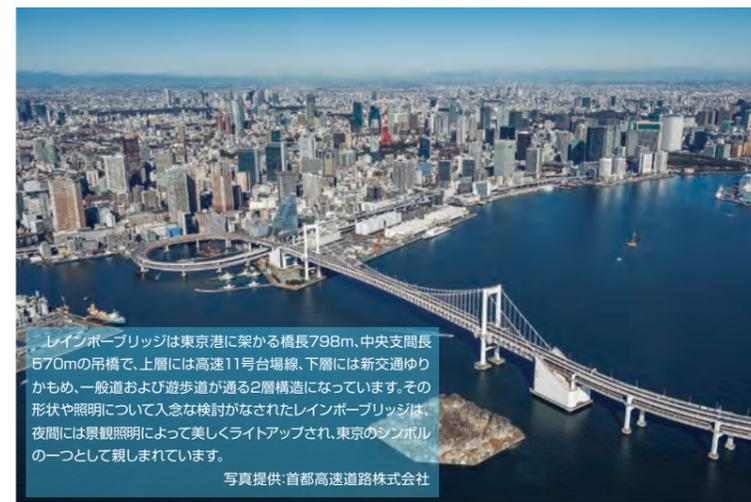
レインボーブリッジは東京港に架かる橋長798m、中央支間長570mの吊橋で、上層には高速11号台場線、下層には新交通ゆりかもめ、一般道および遊歩道が通る2層構造になっています。その形状や照明について入念な検討がなされたレインボーブリッジは、夜間には景観照明によって美しくライトアップされ、東京のシンボルの一つとして親しまれています。
