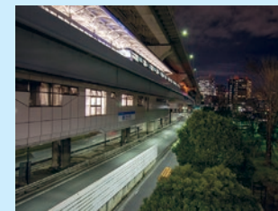
首都高の下にある芝浦ふ頭駅。レインボーブリッジの橋脚まで徒歩圏内
